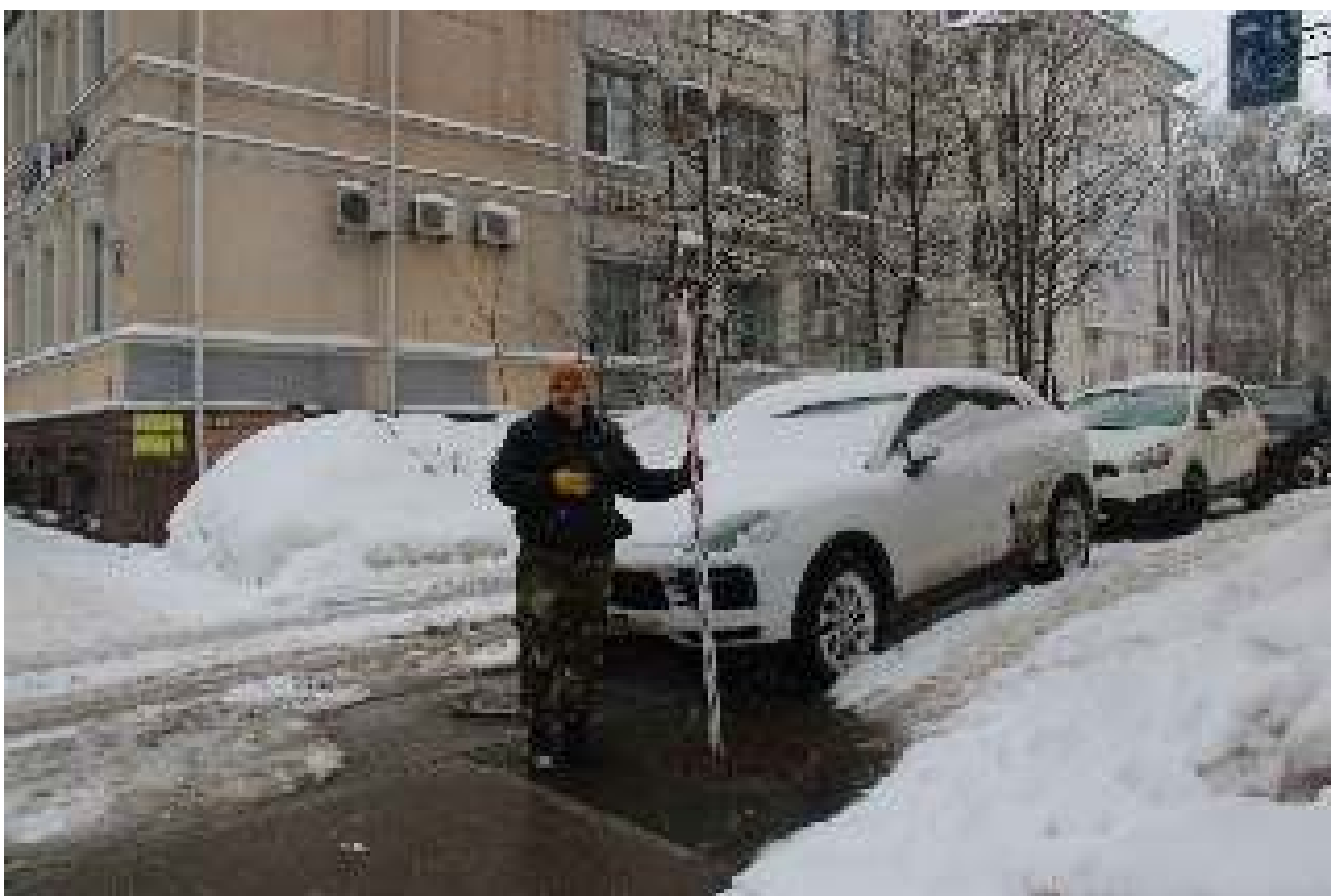
Илл. 20. Общий вид земельных участков, отведенных для расположения объекта: «Теплотрасса отопления от точки в 15 м от ТК-506 у д. 7 по ул. Звездинка в сторону ТК-506-1 у д. 24 по ул. Звездинка до ТК-506-1 у д. 24 по ул Звездинка». Точка фотофиксации 1. Вид с востока.
