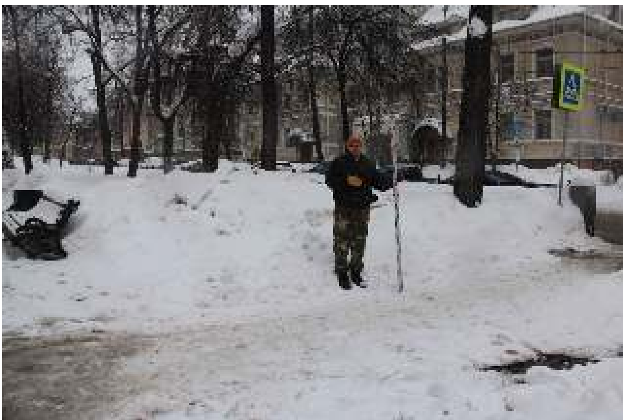
Илл. 24. Общий вид земельных участков, отведенных для расположения объекта: «Теплотрасса отопления от точки в 15 м от ТК-506 у д. 7 по ул. Звездинка в сторону ТК-506-1 у д. 24 по ул. Звездинка до ТК-506-1 у д. 24 по ул Звездинка». Точка фотофиксации 2. Вид с востока.
